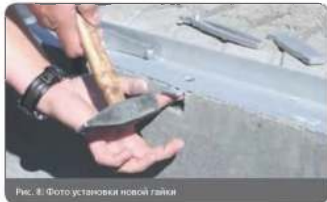
Рис. 9: Фото усадки сменной гайки
